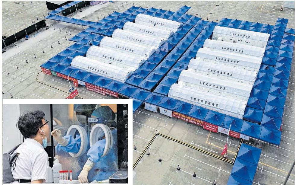
Picha iliyopigwa angani ikionyesha mahabara zilozjengwa kwa hewa iliyopolizwa jijini Chengdu in, China. Jiji la Chengdu limejenga mahabara tano za aina hiyo vya kupima virusi vya Covid-19, na kupanua uwezo wake wa kupima virusi hivyo hadi vipimo 250,000 kwa siku. PICHA NDOGO: Mhudumu wa afya aki-chukua kipimo kutoka kwa mwanamume ili kukikagua. PICHA I AFP
